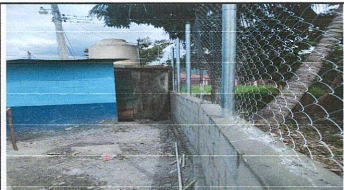
Foto1: Reparacion de muro perimetral y destronque de arboles, que estan dañando muro y direccion de establecimiento.
