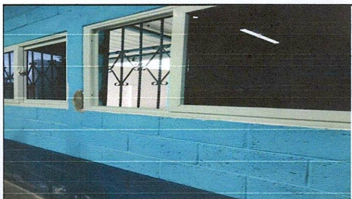
Foto 4: Reparacion de balcones.
